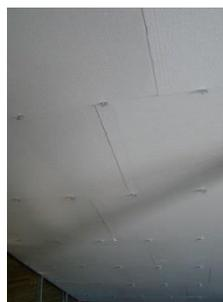
Lorsque tous les panneaux Bespo sont posés, les fourrures sont clipsées sur les pattes de suspente.
